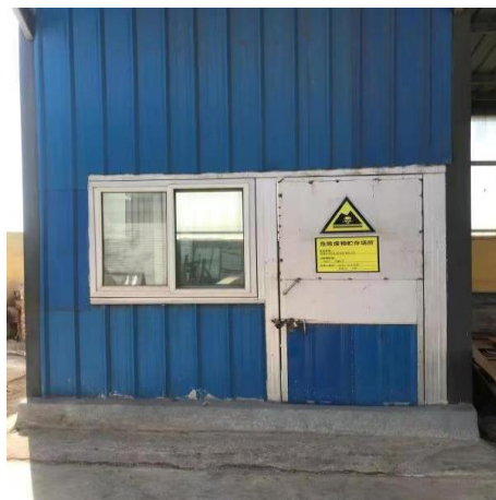
图 3-2 危废暂存间现状图
