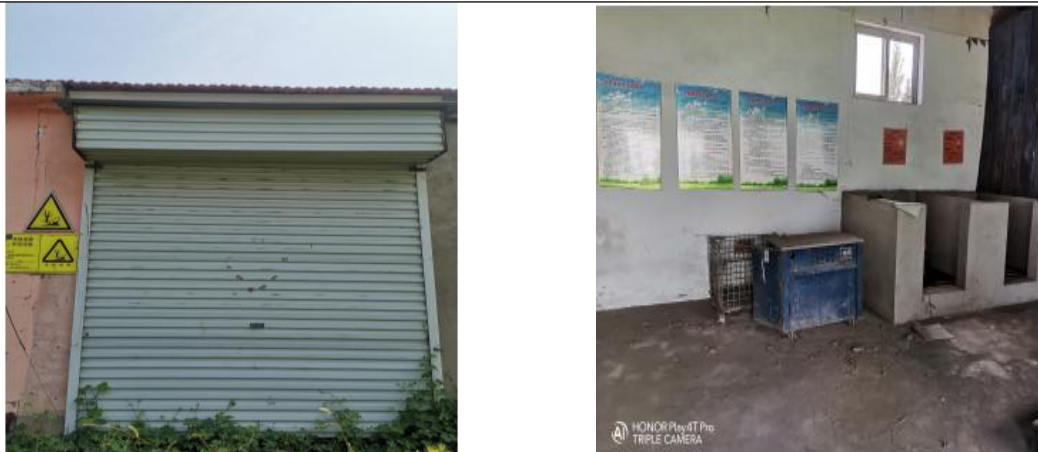
图 3-2 危废暂存间现状图
