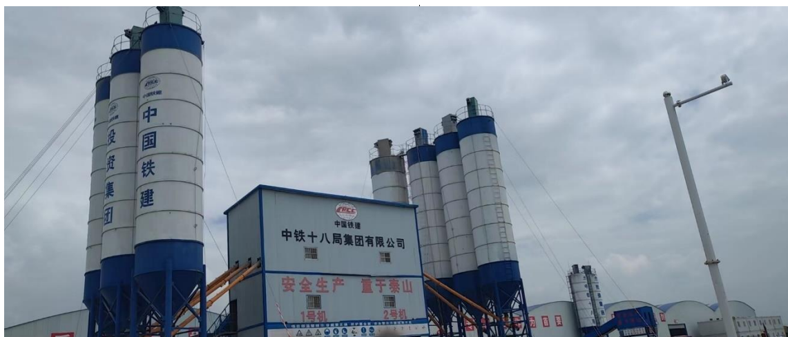
图 3-1 筒仓废气处理设施
