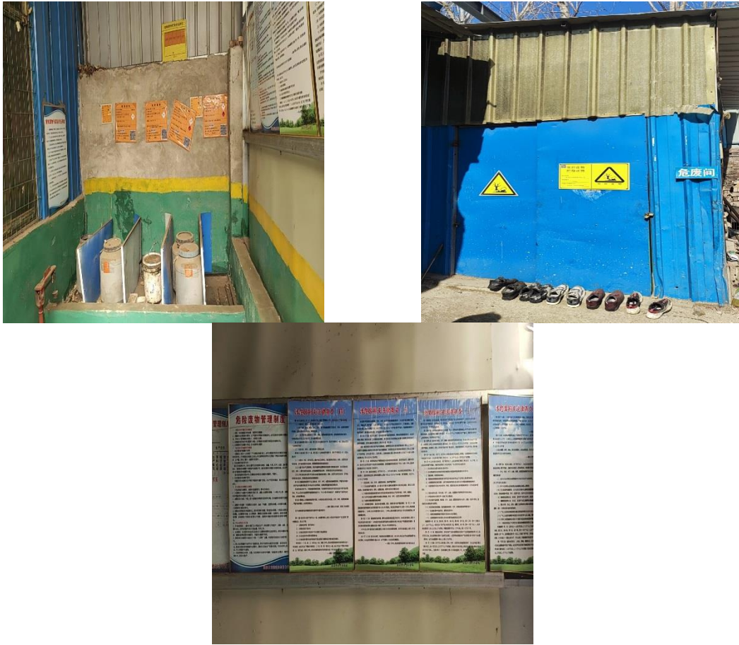
图 3-2 危废暂存间现状图
