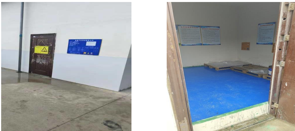
图 3-2 危废暂存间现状图
