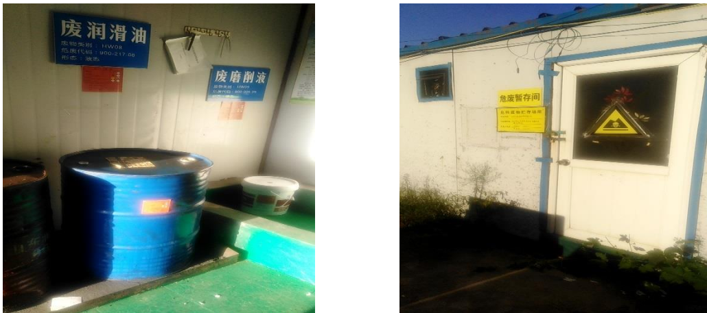
图 3-2 危废暂存间现状图
